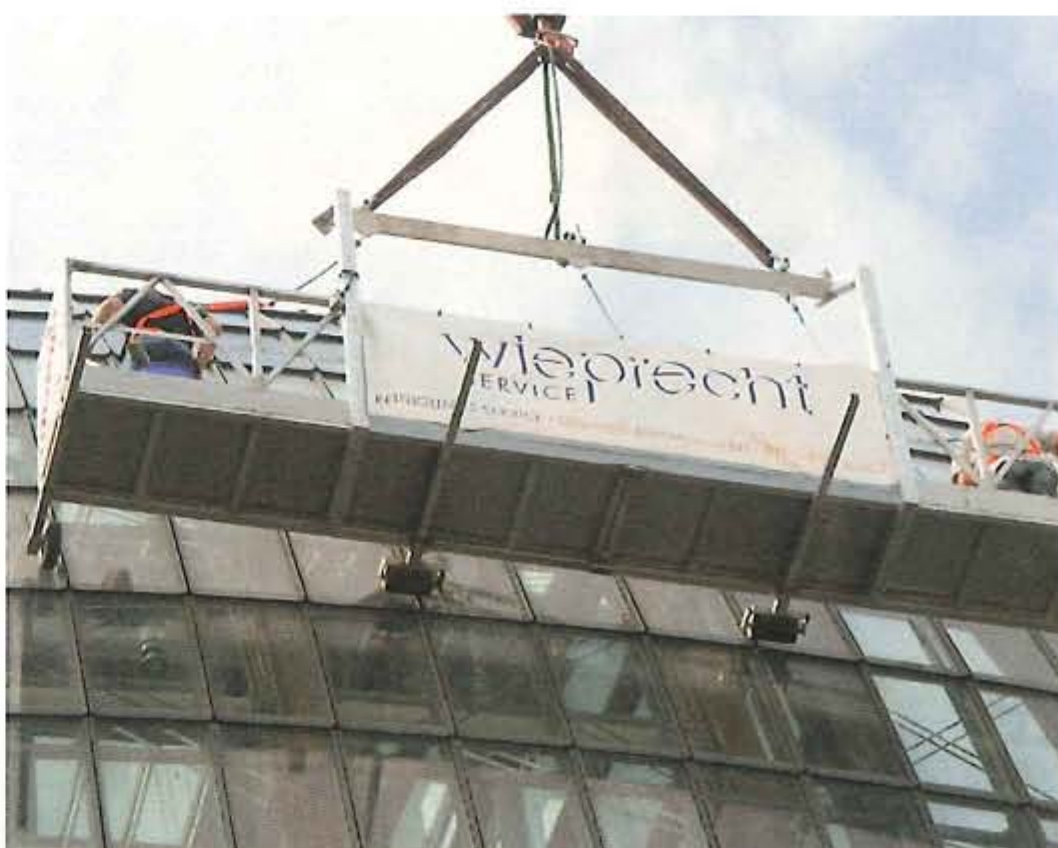
Der mobile Kran mit einer Gittermastfaltkonstruktion erreicht eine Höhe von 42 m. Speziell für diesen Einsatz wurde ein Arbeitskorb entwickelt, der sich an die Fassade anpasst.
