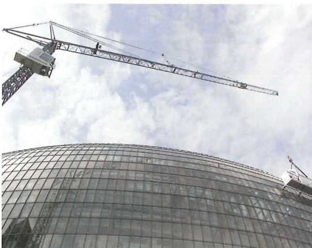
Der mobile Kran mit einer Gittermastfaltkonstruktion erreicht eine Höhe von 42 m. Speziell für diesen Einsatz wurde ein Arbeitskorb entwickelt, der sich an die Fassade anpasst.
